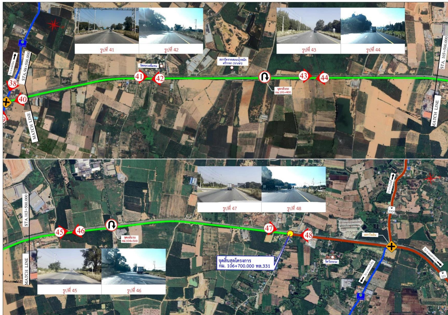
รูปที่ 5.1-1 สภาพทั่วไปตามแนวทางหลวงโครงการ (ต่อ)
